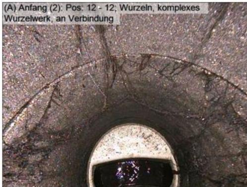
Zustandsdokumentation: Komplexes Wurzelwerk an Verbindungen.
