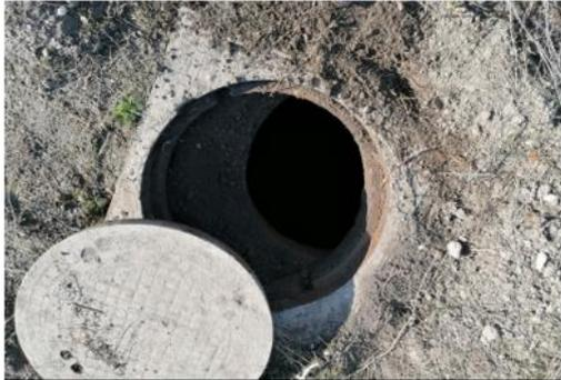
Zustandsdokumentation: Horizontale Verschiebung um 400 mm der Abdeckung und des Rahmens nach 08 Uhr.
