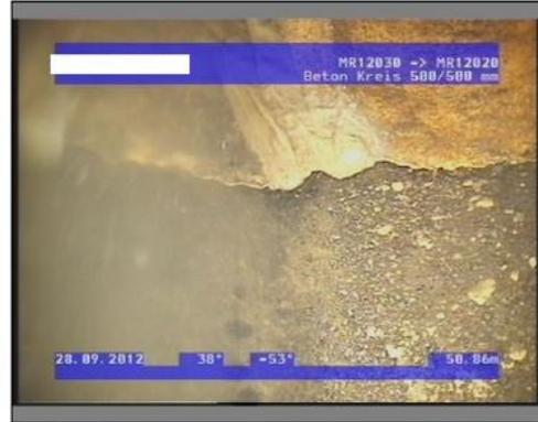
51,11m, Schadhafte Innenauskleidung, Fläche: 5cm<sup>2</sup>, von 4 bis 6 Uhr / Ablösung Auskleidung
