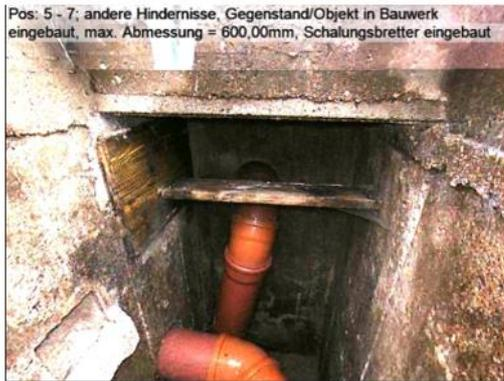
Zustandsdokumentation: andere Hindernisse, Gegenstand im Schachtbauwerk eingebaut (Schalungsbretter); Abmessung 600 mm bei Position zwischen 05 – 07 Uhr.
