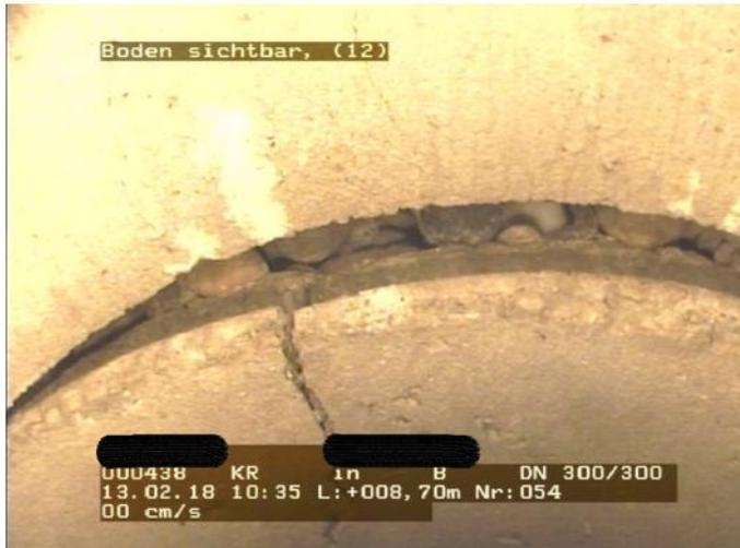
Zustandsdokumentation: Boden sichtbar an Verbindung bei Position 12 Uhr.
