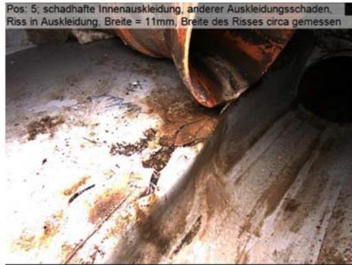
Zustandsdokumentation: Schadhafte Innenauskleidung – Riss von 11 mm in der Auskleidung bei Position 05 Uhr.
