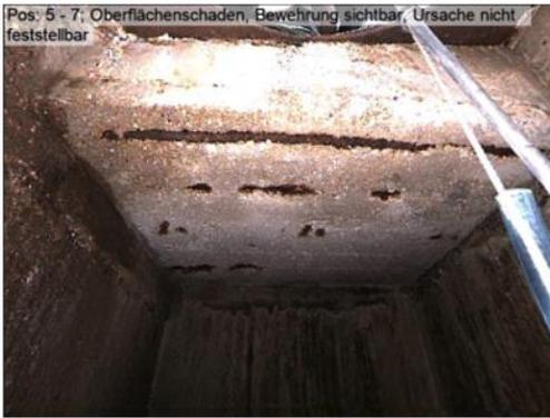
Zustandsdokumentation: Oberflächenschaden, Bewehrung sichtbar an Position zwischen 05 – 07 Uhr, Ursache nicht feststellbar.
