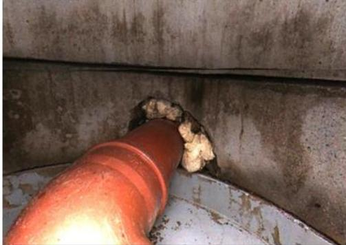
Zustandsdokumentation: Schadhafter Anschluss auf 10 Uhr, teilweise Spalt am Anschlussumfang.
