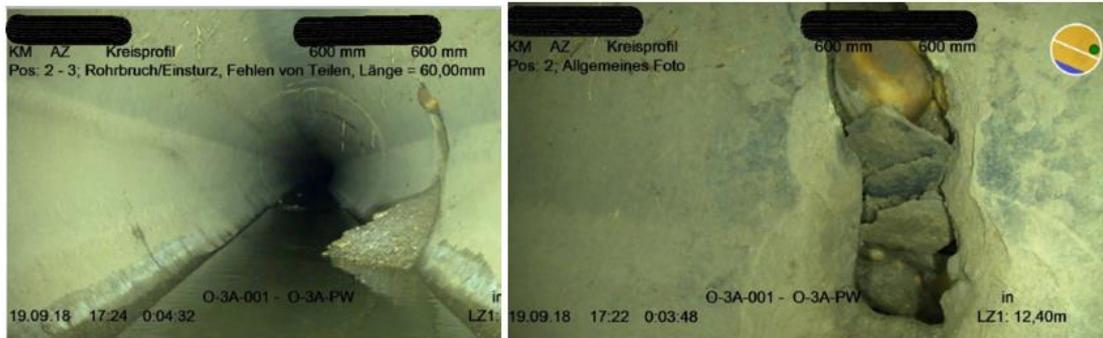
Zustandsdokumentation: Bruch, fehlen von Teilen auf einer Länge von 600 mm.
