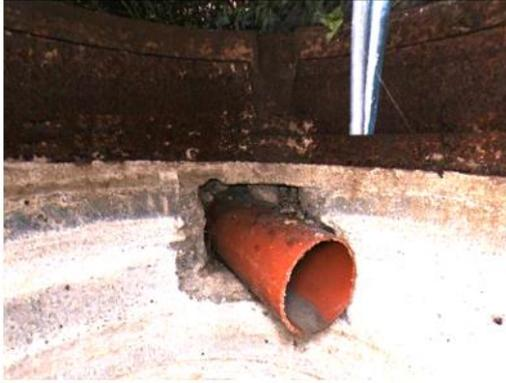
Zustandsdokumentation: Hohlraum sichtbar bei Position 03 Uhr.
