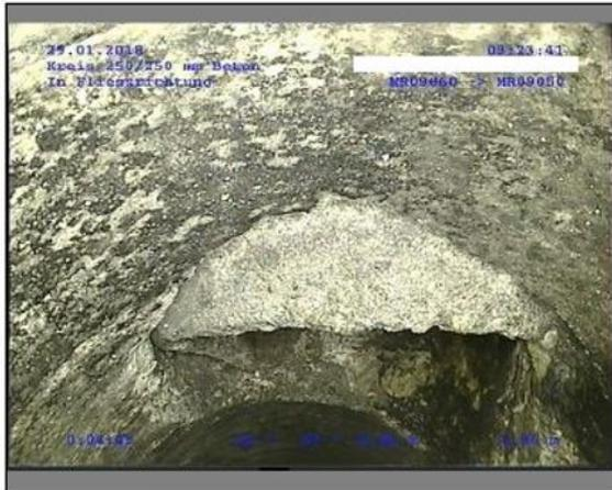
1,39m, Einragender Anschluss, einrag. Länge als Prozentanteil des Durchmessers: 15 %, bei 2 Uhr
