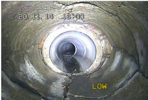
Zustandsdokumentation: Vertikale Deformation, zwischen 12 bis 12 Uhr; Die Haltung hat sich gegenüber der Ursprungsform zu 20 % deformiert.
