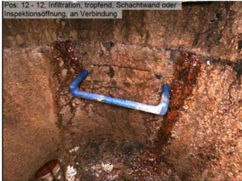
Zustandsdokumentation: Tropfende Infiltration an der Schachtwand von 12 – 12 Uhr.
