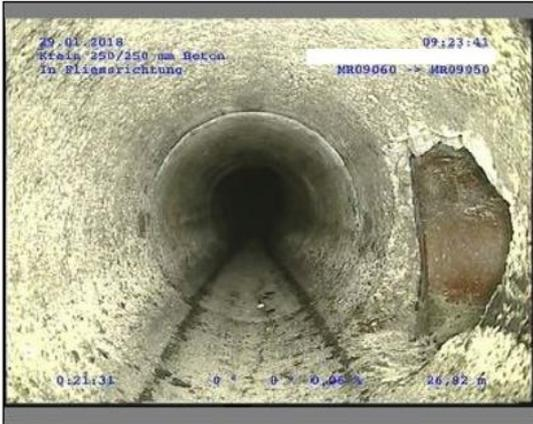
27,31m, Einfacher Anschluss, gemesselt, offen, Höhe: 150 mm, (Breite: 150 mm), bei 3 Uhr / STZ 4cm über Rohrsohle
