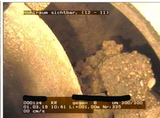
Zustandsdokumentation: Hohlraum sichtbar bei Position 03 Uhr.
