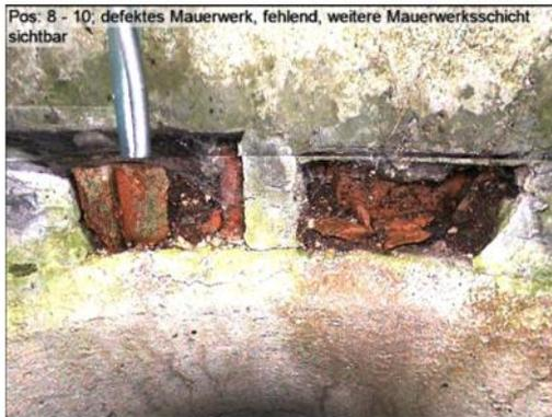
Zustandsdokumentation: Defektes Mauerwerk, eine weitere Mauerwerksschicht fehlt an der Position zwischen 08 – 10 Uhr.
