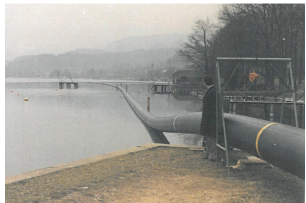
Abbildung 17: Produktion der „Endlosrohre“ in den 1970er-Jahren mit Hilfe mobiler Anlagen und Lagerung der Rohrstränge im See (Bildquelle: RV Attersee).
