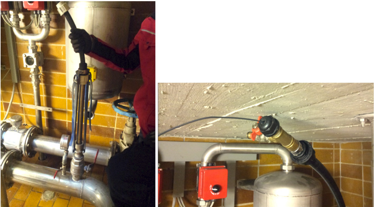
Abbildung 59: Einschwemmverfahren / Einziehen des Stahlseils.
