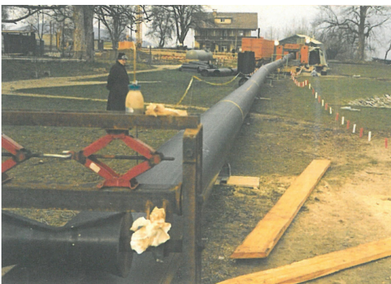
Abbildung 17: Produktion der „Endlosrohre“ in den 1970er-Jahren mit Hilfe mobiler Anlagen und Lagerung der Rohrstränge im See (Bildquelle: RV Attersee).
