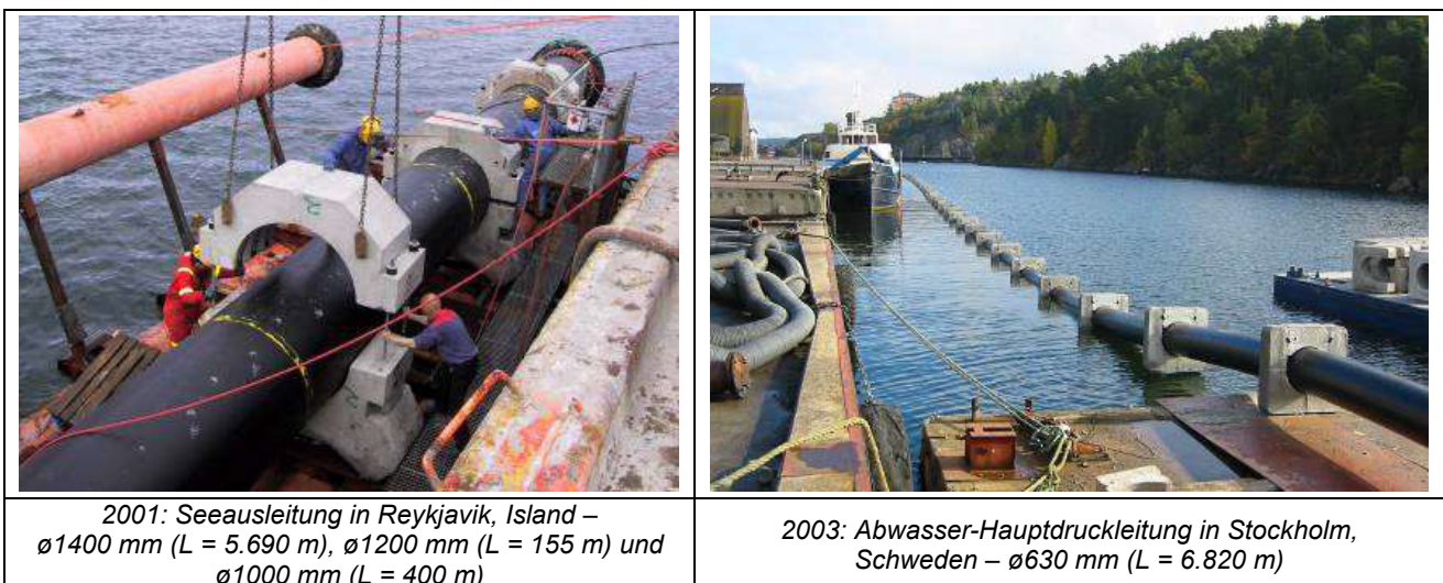
Abbildung 84: Auszug aus den Beispielen von Seedruckleitungen aus anderen Ländern (Quelle: Pipelife Norge AS, Stathelle, Norway; http://www.pipelife.com [14.04.2015]).
