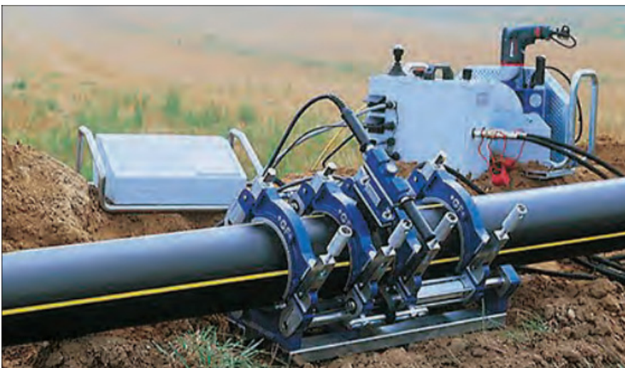
Abbildung 9: Herstellung einer Stumpf-/Spiegel-Schweißung (Jansen, 2014).
