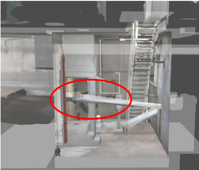
Abbildung 48: Überlagerung photogrammetrisches und 3D-Modell SBW AWW Großache-Nord
