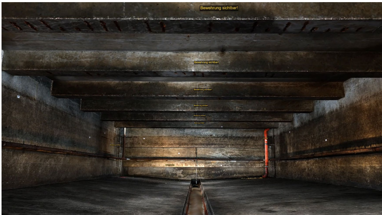
Abbildung 104 Ansicht aus Rundgangvideo mit Zustandsbeschreibungen (gelb) direkt am digitalen Modell
