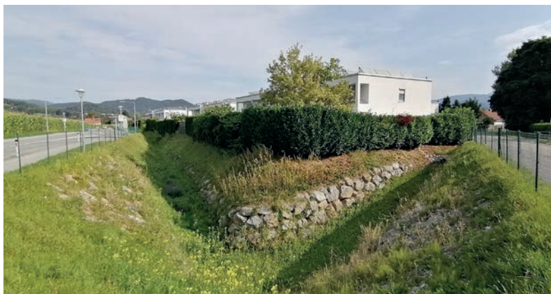
Abb. 12: System mit Rasen, Versickerungsbecken, Gratweinstraßengel (A14)
